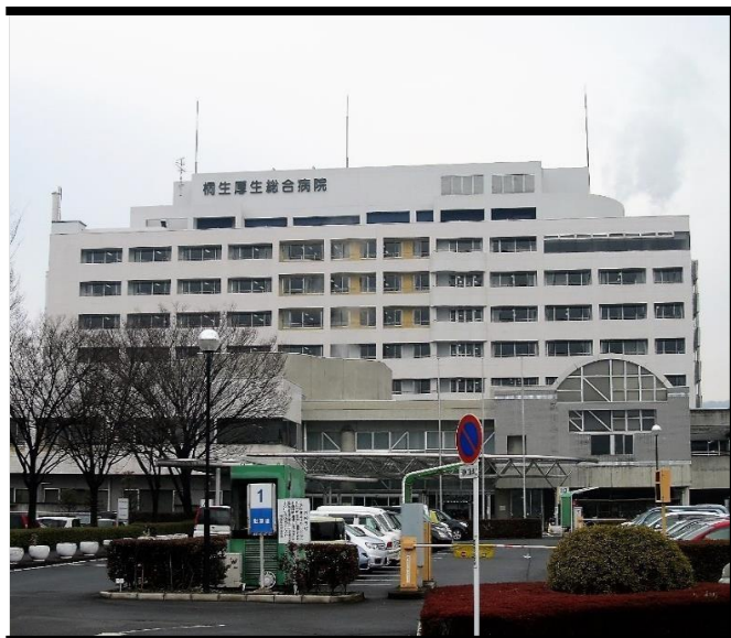
図 10 桐生厚生総合病院外観
