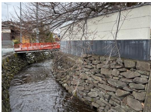
城堀川と布積み石垣
